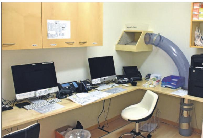
Dank der Rohrpost gelangen die Medikamente unter der Dorfstrasse durch in das gegenüberliegende Gebäude.
